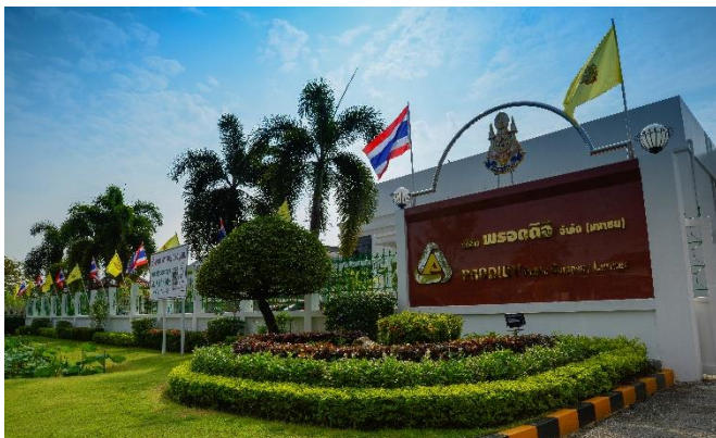
สำนักงานใหญ่ จ.นครปฐม
