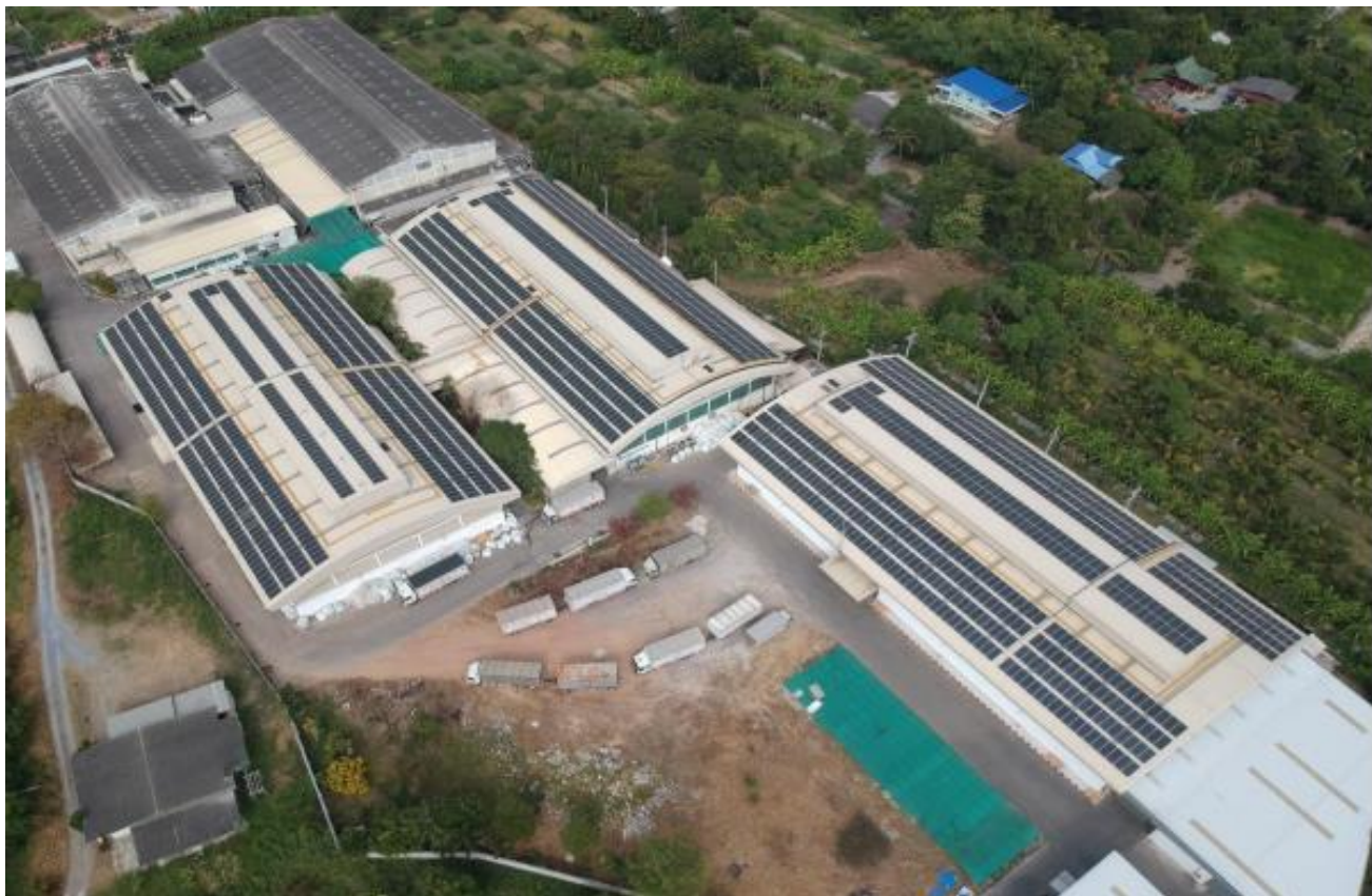
การติดตั้งแผงโซลาร์เซลล์บนหลังคาอาคารผลิตของบริษัท จำนวน 3 อาคาร
