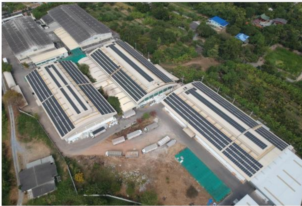
การติดตั้งแผงโซลาร์เซลล์บนหลังคาอาคารของบริษัท
